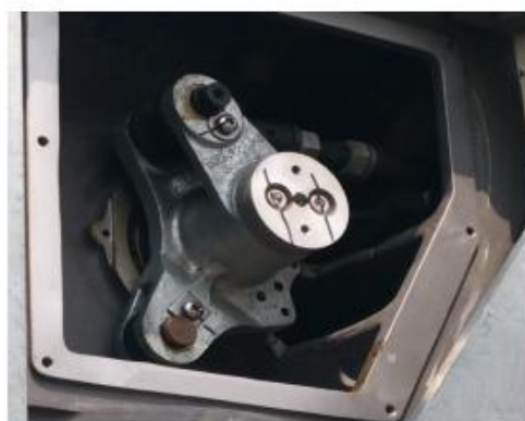
35KV SF6 开关传感器安装
